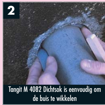
Met een stomp voorwerp duwt men de Dichtsok in de doorvoer
