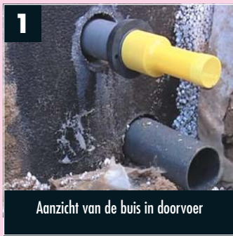
Tangit M 4082 Dichtsok is eenvoudig om de buis te wikkelen
