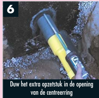
Tangit M 4082 Dichtsok is eenvoudig om de buis te wikkelen
