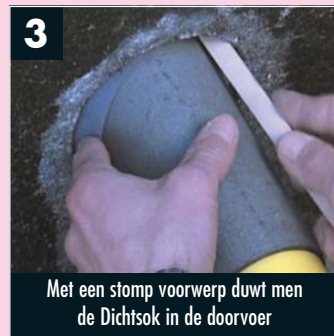
Tangit M 4082 Dichtsok is eenvoudig om de buis te wikkelen
