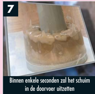
Met een stomp voorwerp duwt men de Dichtsok in de doorvoer
